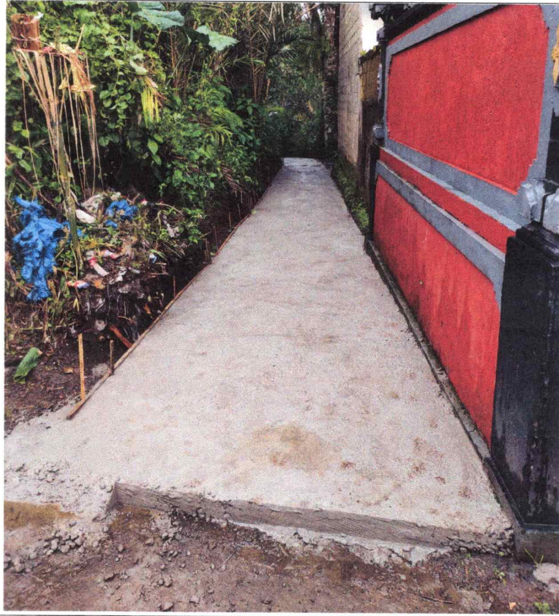
Dokumentasi Rabat Beton Jalan Usaha Tani Wates Kaja
