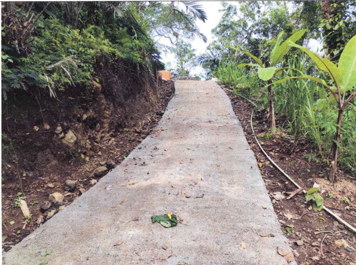
Dokumentasi Rabat Beton Jalan Usaha Tani Kastoan
